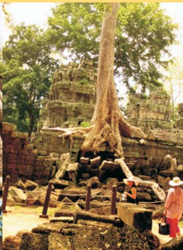
▲塔普倫寺樹根穿破建築
