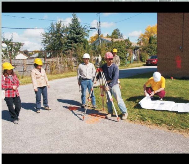
▼左圖為地盤測量。右圖為倒地基水泥。
